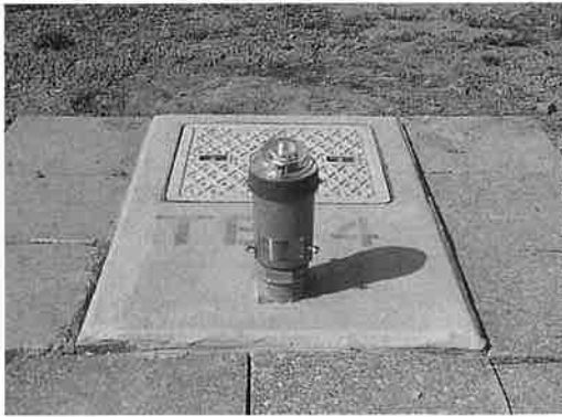
LEDの誘導路灯
