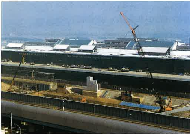
▲建設中、第二ターミナル
